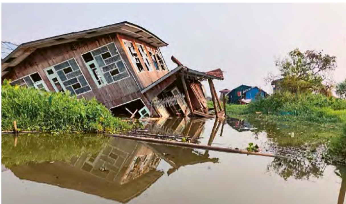
Zerstörung in der Region rund um den Inle-See: Nach dem schweren Erdbeben sind zahlreiche Häuser unbewohnbar. Der RC Zurich Plus unterstützt über ein lokales Netzwerk 500 betroffene Haushalte mit dringend benötigter Hilfe.
